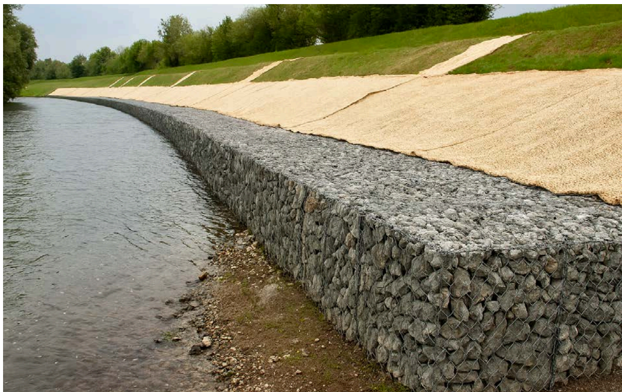
Kőháló gabion támfal
