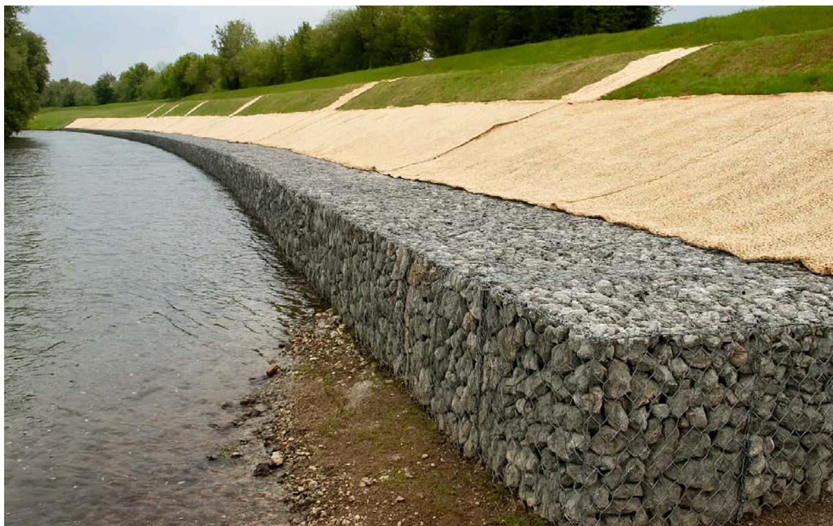
Kőháló gabion támfal
